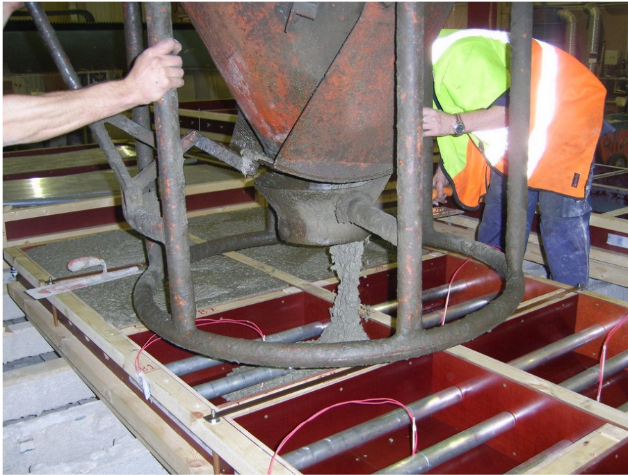
Figur 4-6 Gjutning av element
